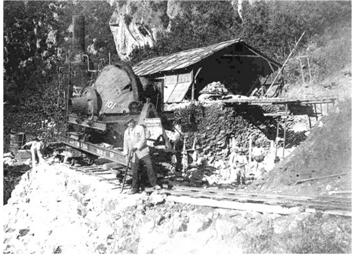
Chantier de construction du barrage
