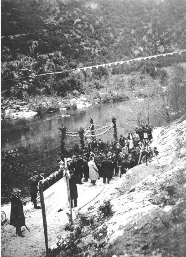
La pose de la première pierre Le 12 avril 1922
